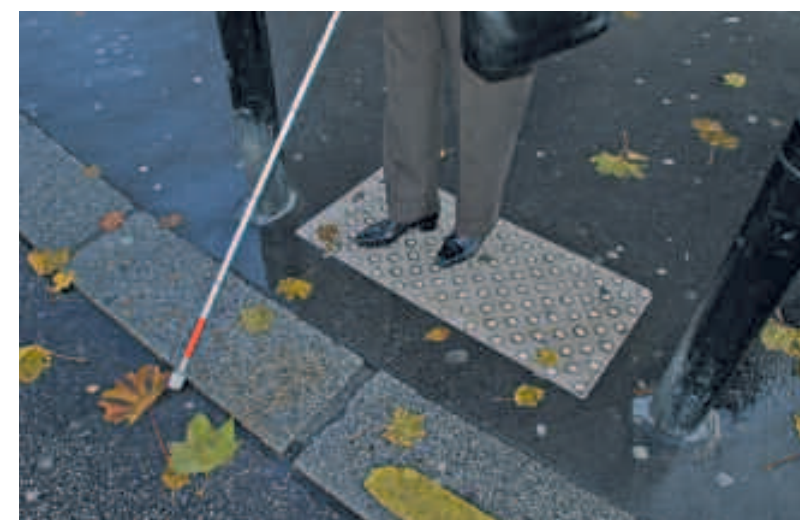
Des bandes podotactiles et des feux sonores autour de l'Hôtel de Ville
