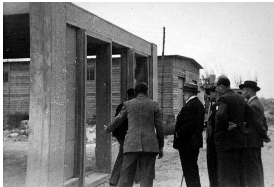
Auguste Perret observant un prototype de façade
